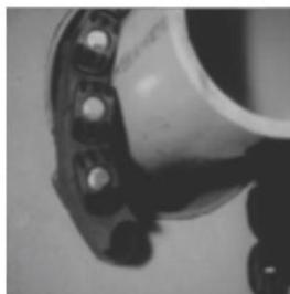
2. Соедините два конца цепи. Расслабьте заднюю пластину, работающую на сжатие, настолько, чтобы цепь ЗУКП можно было бы свободно перемещать в кольцевом пространстве.
