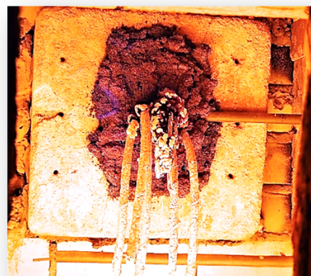
б) проходка внутри огневой камеры испытательной печи
